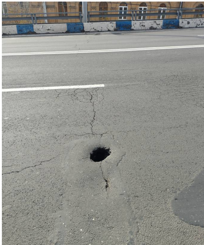
Նկար 3. Դեֆորմացիոն կարի տեղամաս (N11 հենարան)
